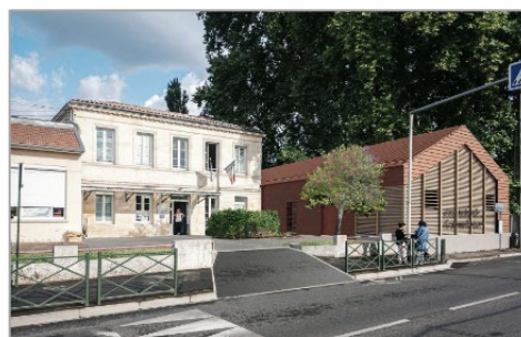
Travaux sur la maternelle F. Buisson à Bègles
