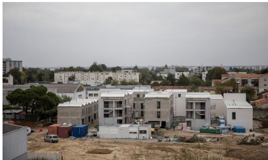
Photo chantier îlot 9.12 – Charme/P1 (ex CASTORAMA) - décembre 2022
