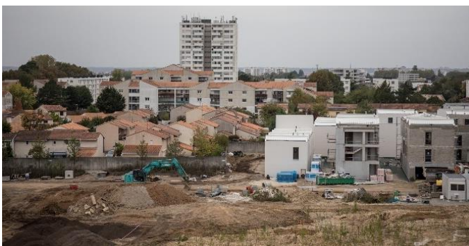
Photos chantier îlot 9.12- Tamaris (P4) (ex CASTORAMA) - décembre 2022
