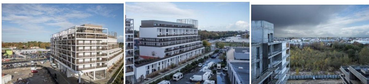
Photos chantier îlot 4.3 - Park Avenue (ex FIAT) - décembre 2022© Sabine Delcour
