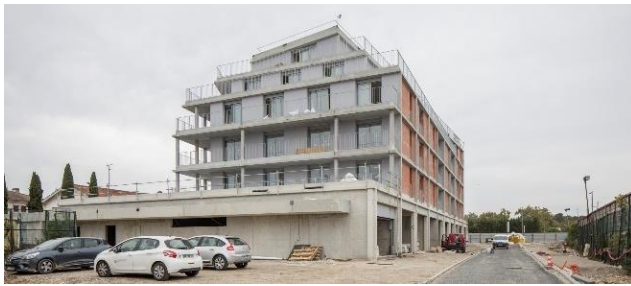
Photo chantier îlot 9.6.1 – Corylus/P5 (ex CASTORAMA) - décembre 2022
