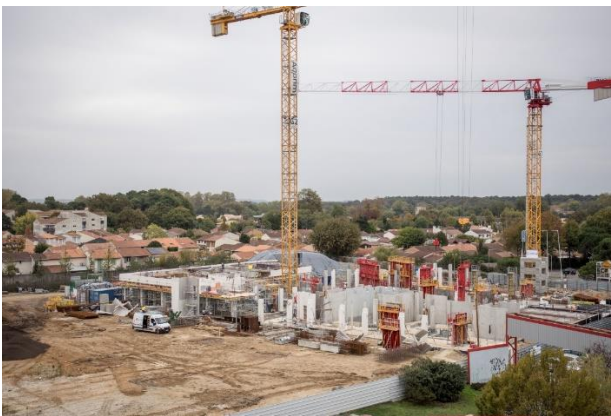
Photo chantier îlot 9.12 – Euphorbia/P3 ex CASTORAMA) - décembre 2022
