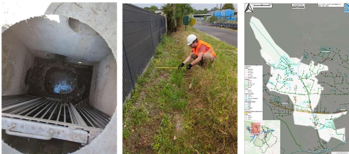
*(de gauche à droite) Dégrillage sur réseau enterré en amont d'une solution compensatoire - Prise de côte d'un fossé - Exemple de cartographie des inspections à l'échelle d'un bassin versant*
