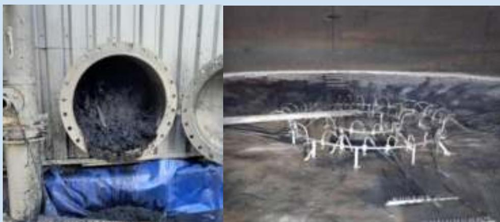
Cette vidange a été suivie de travaux sur la période d'octobre à décembre 2023 afin d'assurer la réfection de l'étanchéité du dôme (intérieur et extérieur), du système de brassage des boues ainsi qu'un bon nombre de vannes présentes pour le process de cet ouvrage. En parallèle de ce chantier, le gazomètre a également été remplacé.
