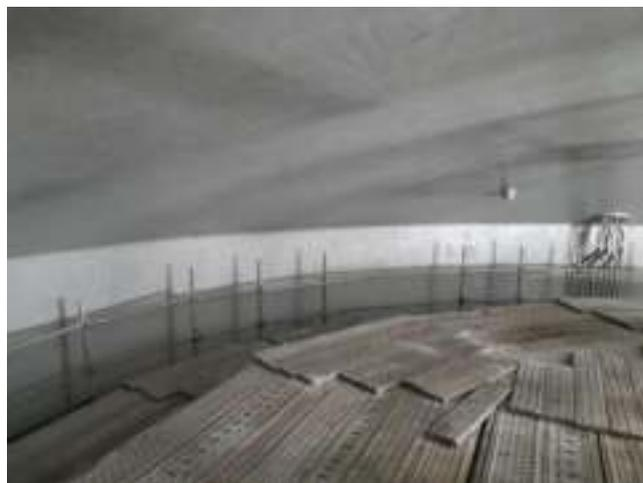
**PHOTOS 28 et 29 - PAT.3 Peinture époxy dôme intérieur du digesteur**
