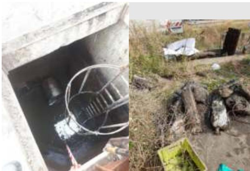
L'opération a consisté à enlever environ 3m3 de déchets solides (pneus, plastiques, déchets organiques ...) permettant ainsi aux régulateurs hydroslide de refonctionner normalement. Un curage de la canalisation Ø1200mm entre l'ouvrage et le bassin a été réalisé également. Cette opération a eu pour but d'éviter des remontées d'eaux de Garonne chargées
