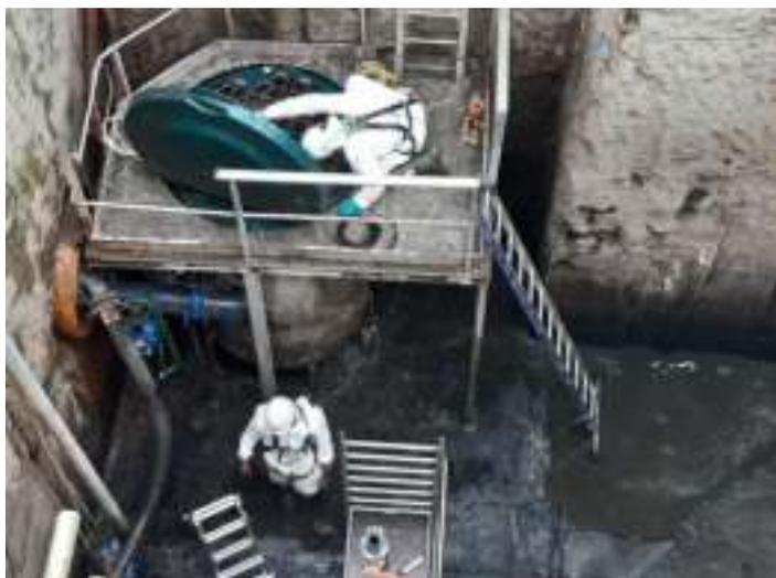
Bourgailh barre anti chute et renforcement du garde corps
