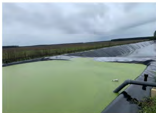
Site du Temple : Vue des nouveaux bassins
