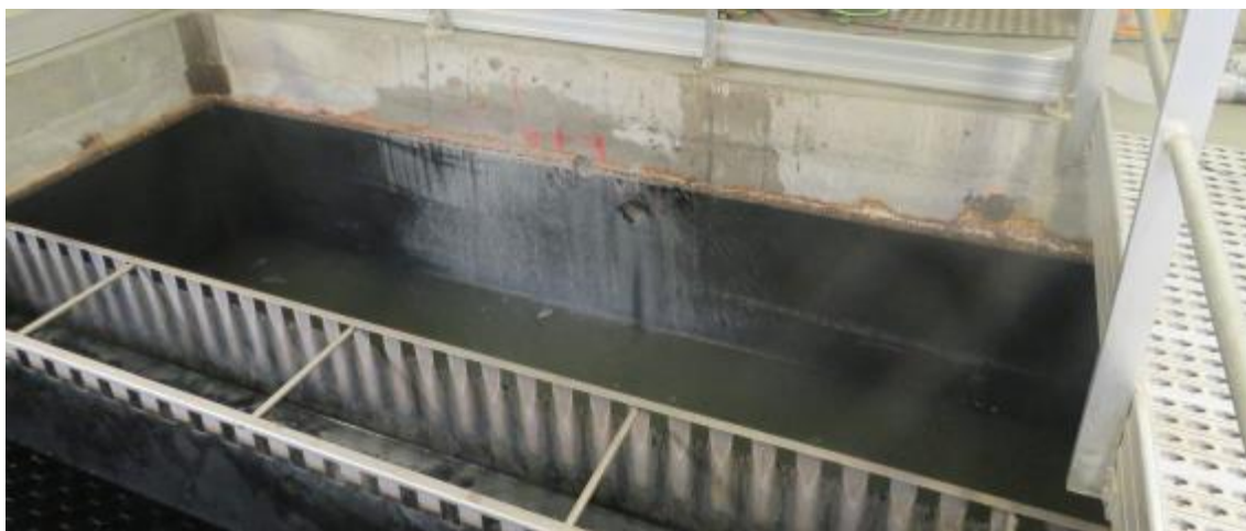
Prise de vue photographique du bassin du bâtiment 21
