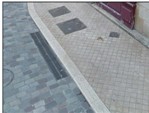
Exemple de la rue Bouffard à Bordeaux
