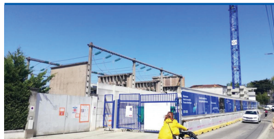
Vue du poste source en travaux depuis l'avenue de Lognac. @ Crédit photo : O.D
