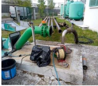
Opération de diagnostic du forage de Jourde
