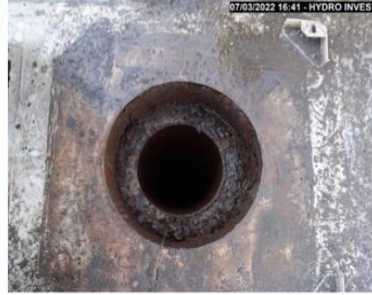
Opération de diagnostic du forage de Gauchon
