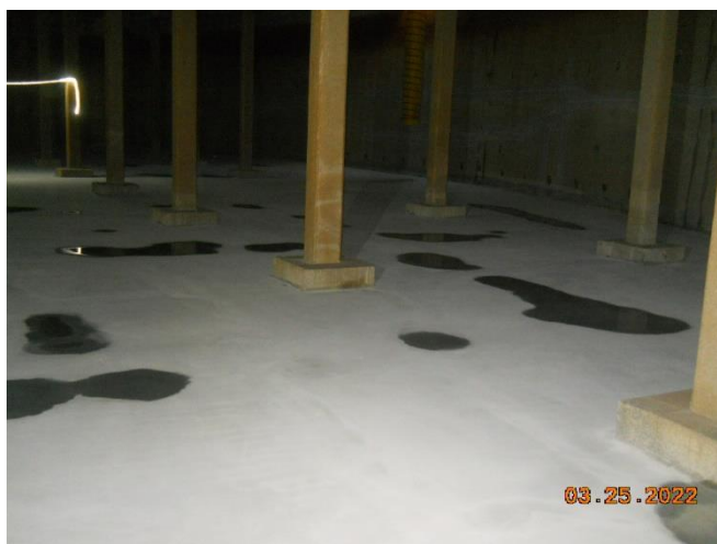
Réservoir de Cap Roux en fin de chantier
