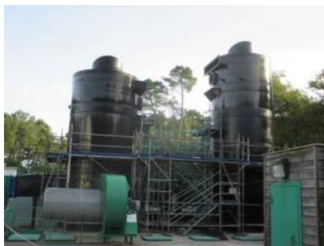
Usine de Gamarde à Saint-Médard-en-Jalles :
