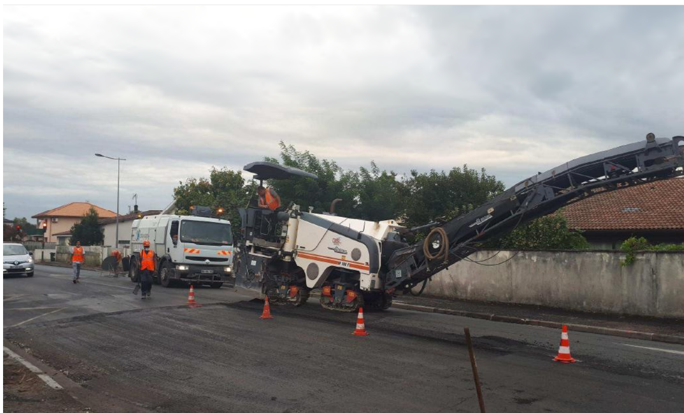
PHOTOGRAPHIE 1 - EXPL.4.3 Rabotage de voirie
