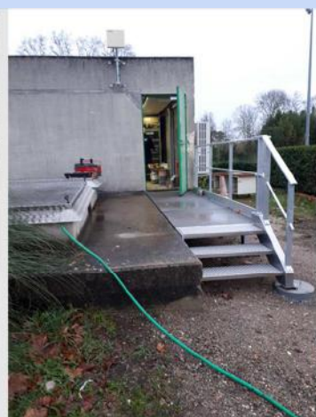
Mise en place d'une plate forme de manipulation des équipements lourds
