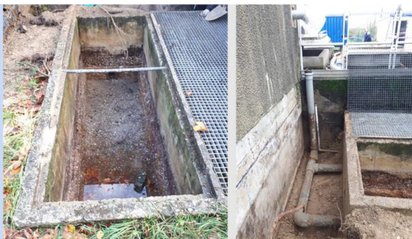
Filtre désodorisation génie civil et tuyauterie HS
