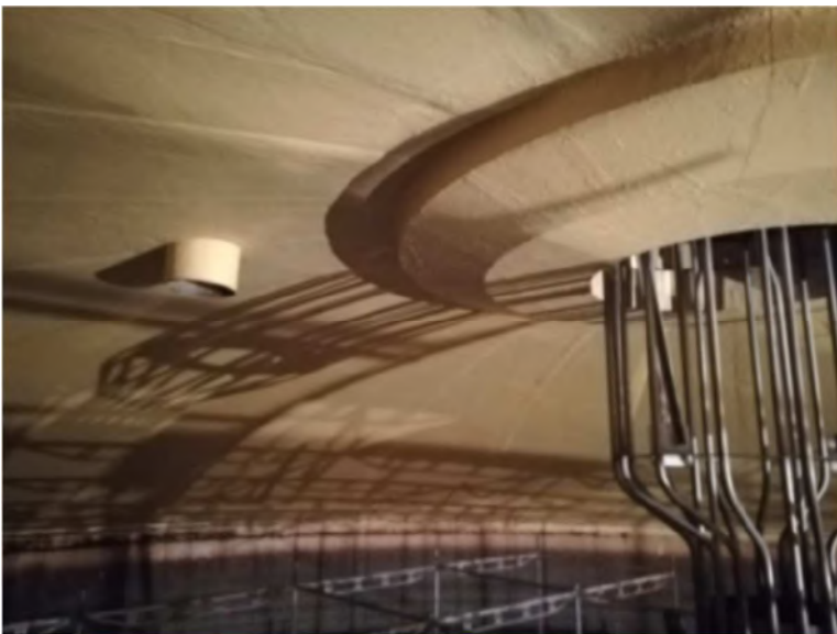
PHOTO 16 - PAT.3 Peinture époxy dôme intérieur du digesteur 2 (51)
