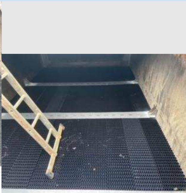
Nouveau garnissage biofiltre CD
