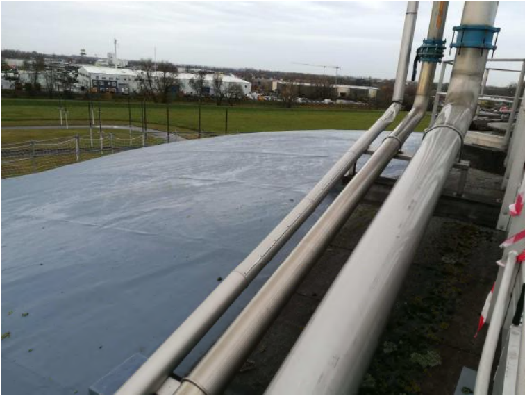
PHOTO 15 - PAT.3 Reprise des toitures de digesteur 2 (51)
