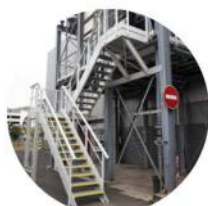
L'escalier silos boues séchées
