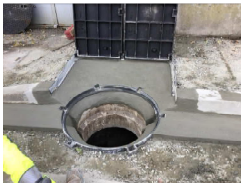
PHOTO 4 - PAT.1.2.9 Clapet de protection réseau du ruisseau d'Ars rue Jules Verne
