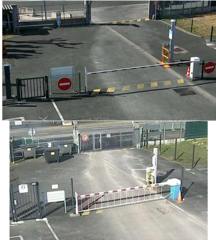
PHOTO 1 - ORGA 3.3.2 Photos avant (à gauche) et après travaux (à droite) de l'entrée du 88 cours Louis Fargue
