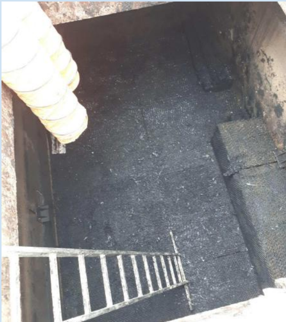
Ancien garnissage biofiltre CD
