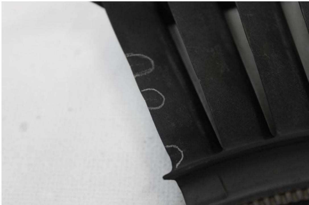
Photo 18 – Fissuration du bord de fuite de l'aube de turbine de l'étape 3
