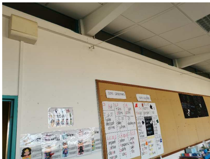
Eléments vitrés en partie haute des cloisons séparatives visibles côté classe
