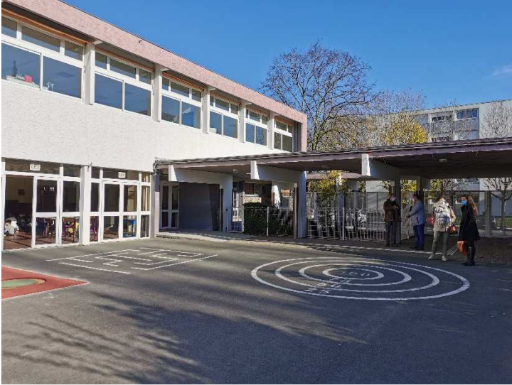
Trames poteaux-poutres visibles en façades
