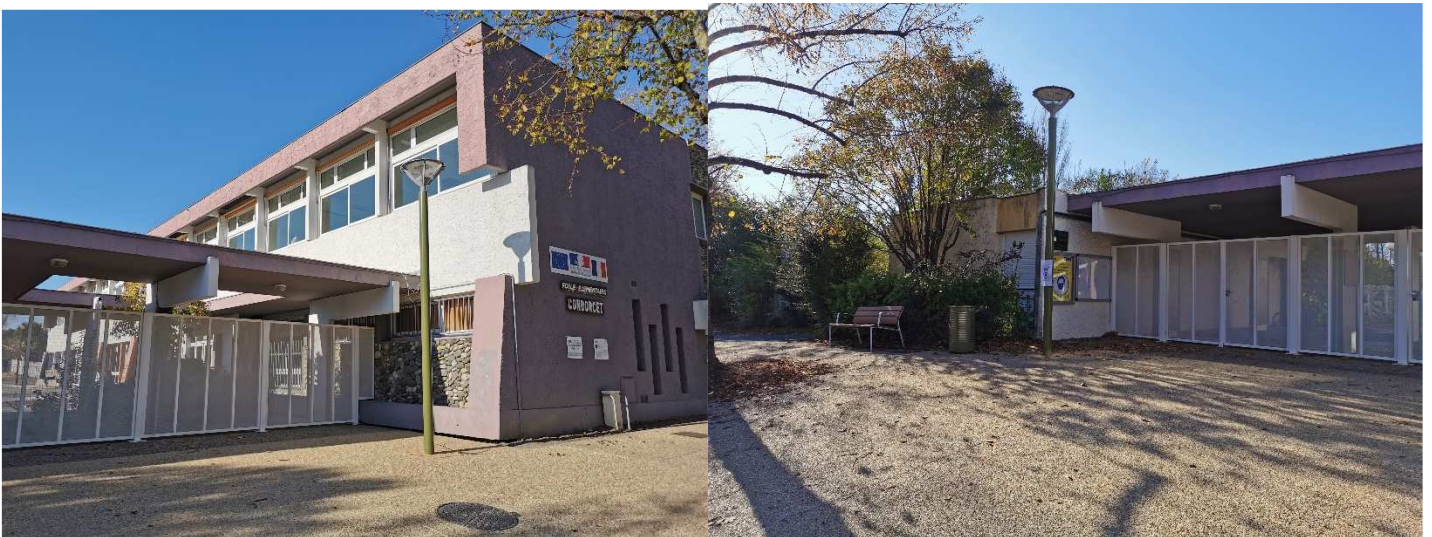
Façades du bâtiment principal, du préau d'entrée et des logements de fonction sur la rue de Valvert
