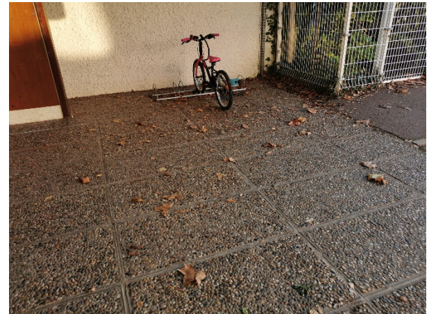
Rack à vélos sous le préau d'entrée
