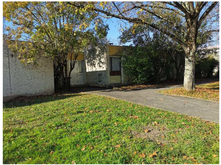
Vue des Logements de fonction depuis la rue de Valvert
