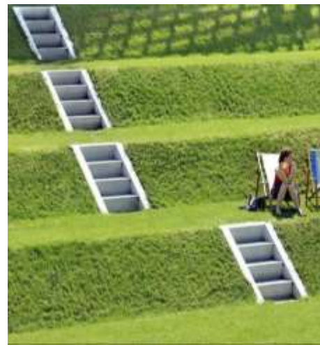
Exemple d'emmarchements dans talus pour accessibilité piéton
