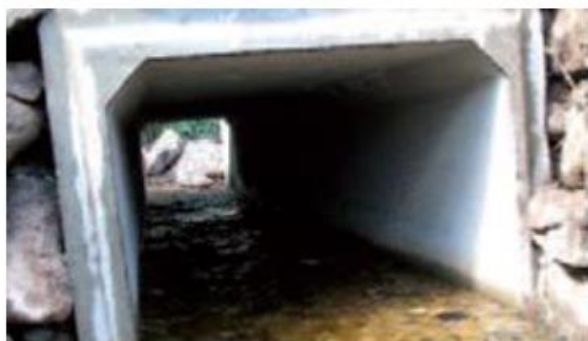
Figure 35 : Solutions de franchissement de cours d'eau : dalot (Mourey & Pereira, 2009) à gauche / passerelle en bois (De Vos & Petit frère, 2008) à droite
