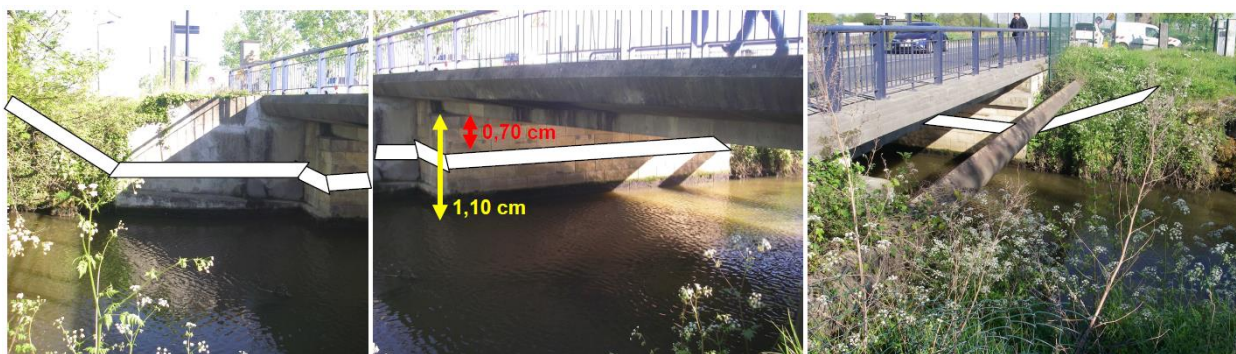
Figure 31 : Position schématique de l'emplacement de l'encorbellement sous le pont
