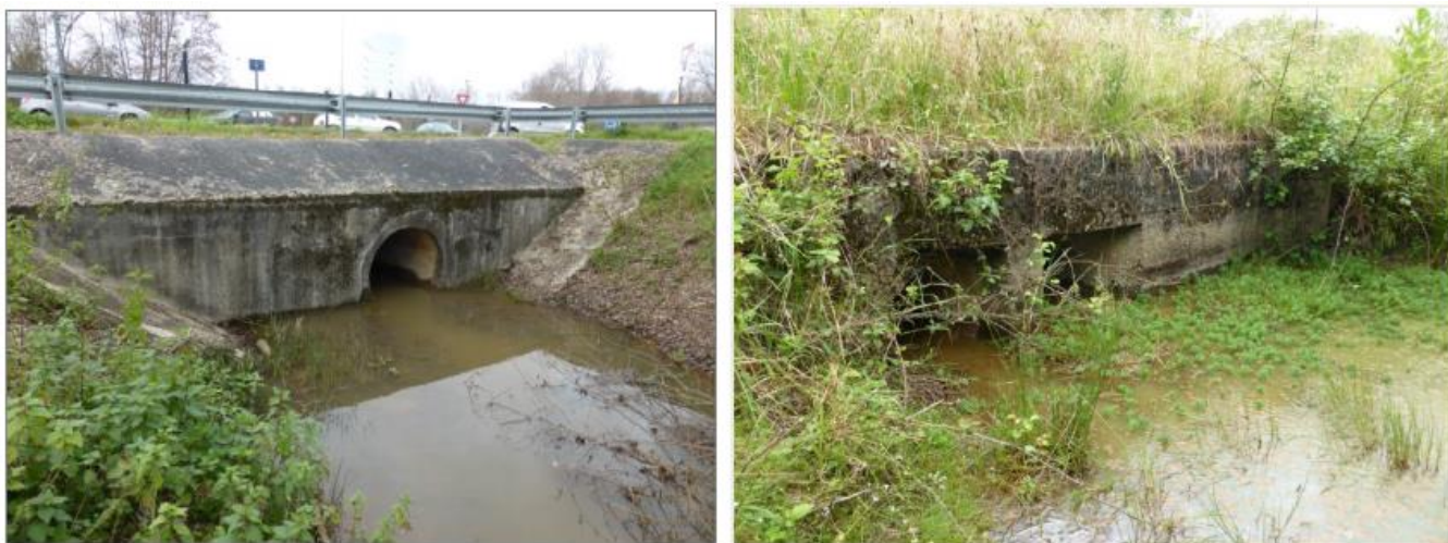
Figure 19 : Ouvrage de la Jalle Conrad, au niveau du boulevard Chaban-Delmas (à gauche) et de l'allée du Bois (à droite) (Gereco & Lindénia - juin 2014)
