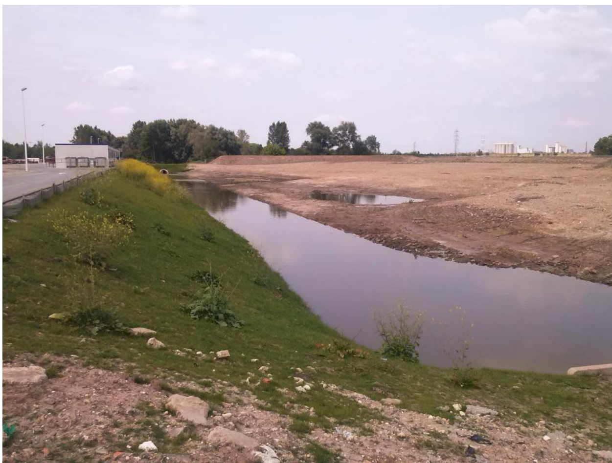
Figure 40 : Vue des terrassements réalisés en 2013 (INGEROP)
