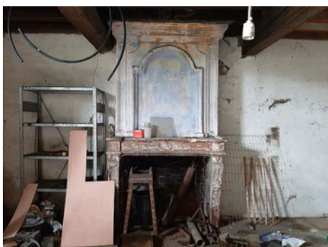
Vue intérieure de l'aile Sud
