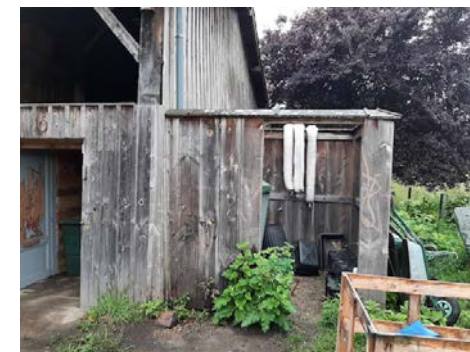
Petit appentis accolé à la grange
