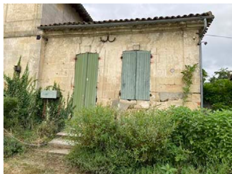
Aile Nord de la maison
