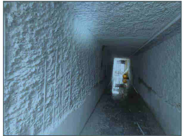
Voiles après hydro-démolition
