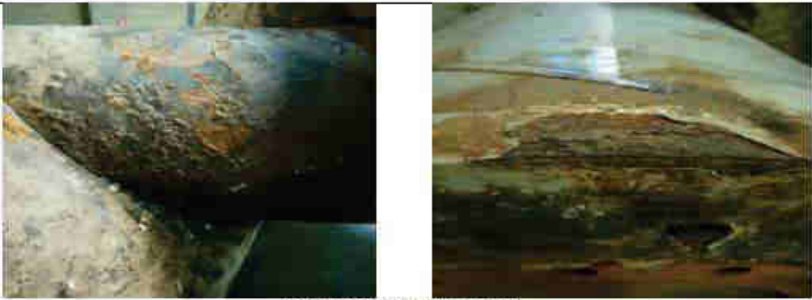
Oxydation importante sur le fût
