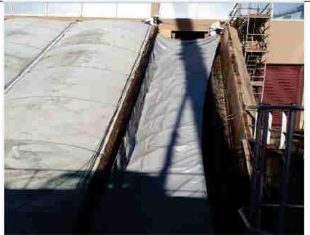
Mise en place de la bâche anti-odeurs
