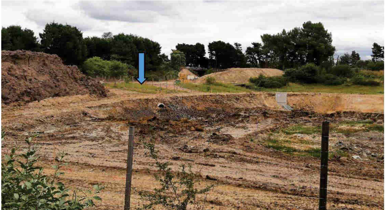
PHOTOGRAPHIE 7 - ENV.4.1. Zone préservée sur le chantier de Lamothe-Lescure et vue sur plan
