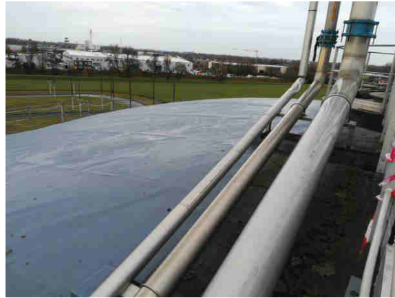
Nouvelle étanchéité extérieure du dôme
