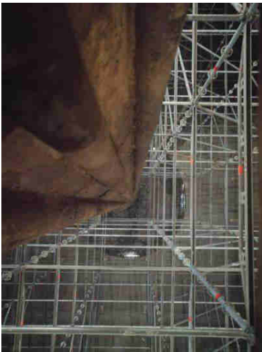
Échafaudage installé à l'intérieur de l'ouvrage
