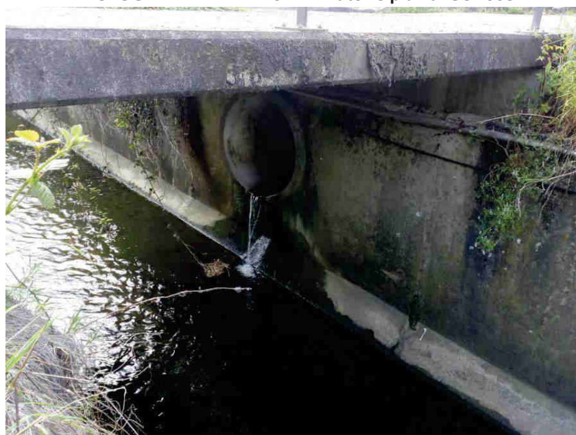
PHOTOGRAPHIE 1 - ENV.3.2. : Exutoire pluvial GUA008
