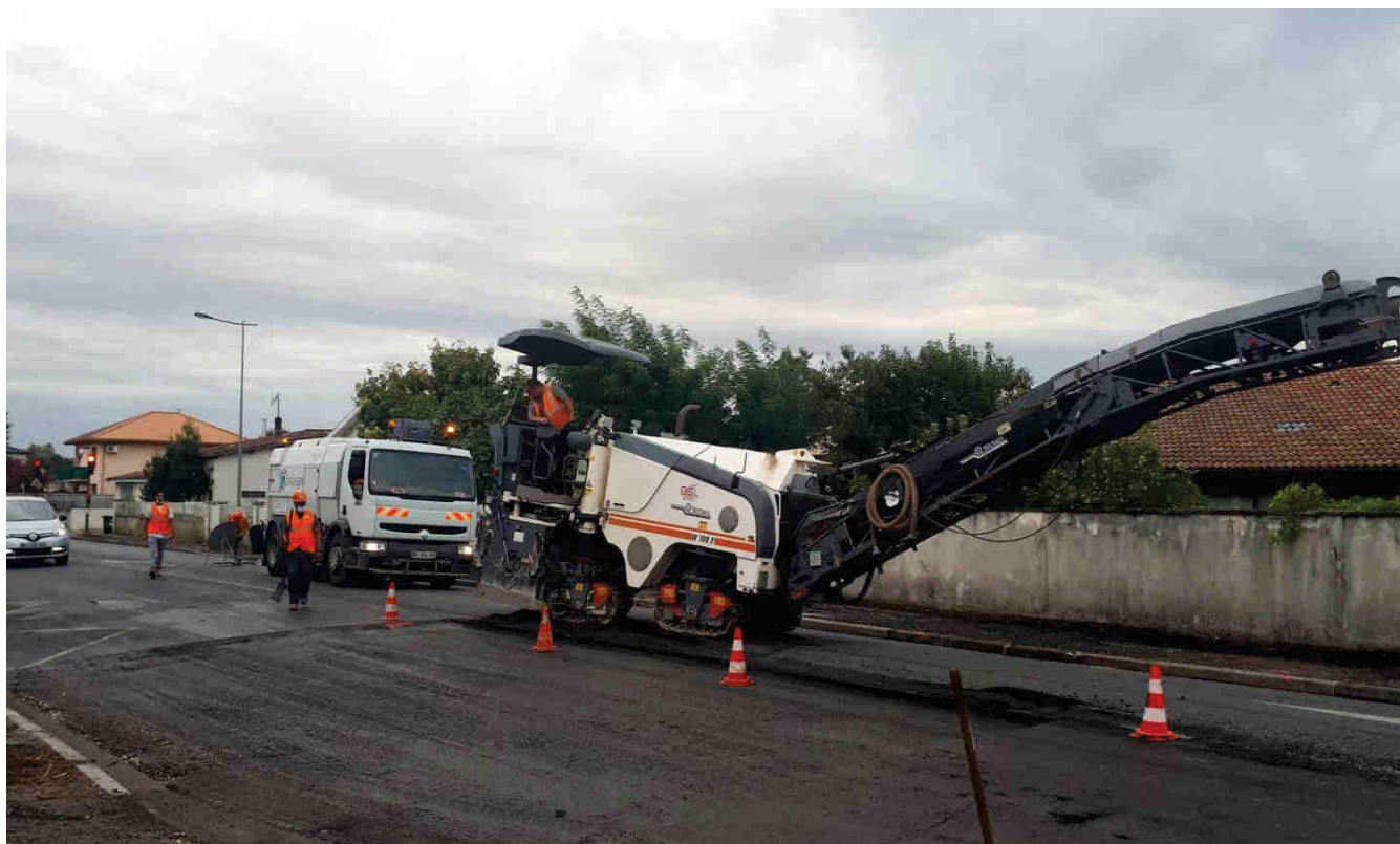
PHOTOGRAPHIE 1 - EXPL.4.3 Rabotage de voirie
