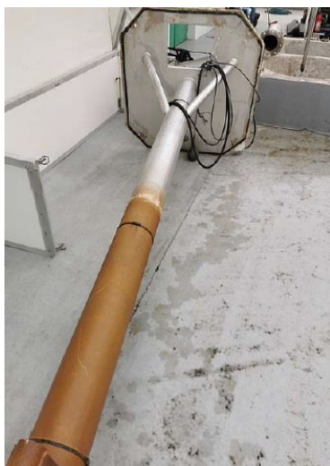
Opération de diagnostic du forage de Budos
