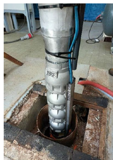
Opération de diagnostic du forage de Servantin
