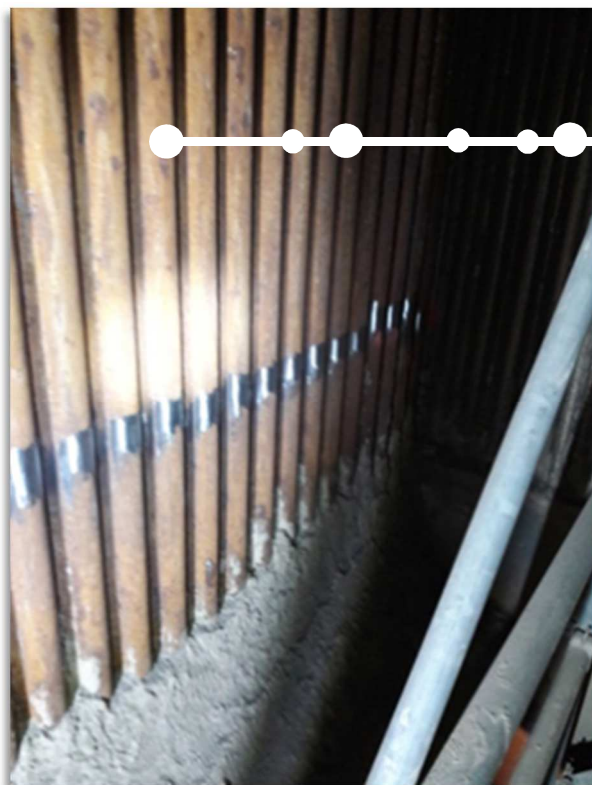
Figure 18 : Photographie de préparation de surface sur les tubes de chaudière
