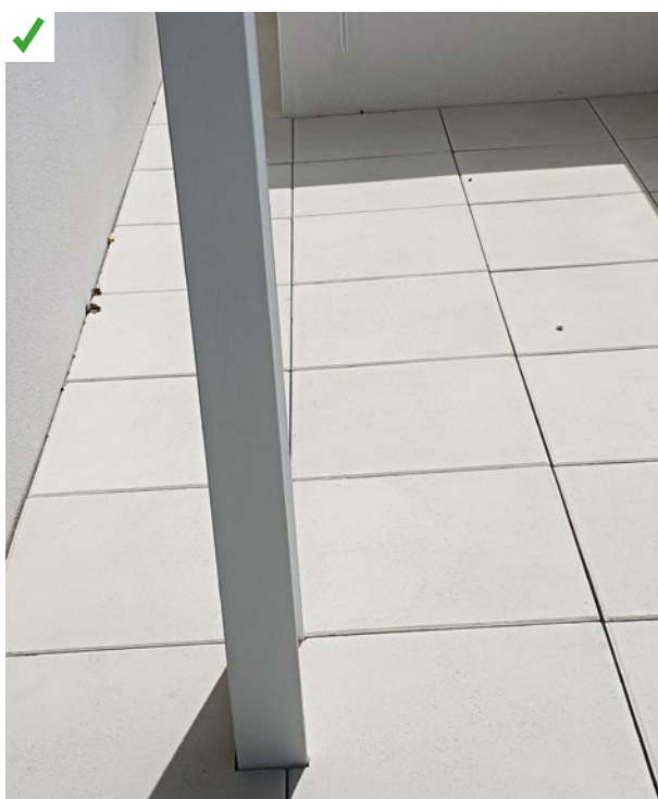
Un enduit extérieur et un carrelage de terrasse de couleur claire (coefficient d'absorption de 0.2) participent au confort d'été en réfléchissant le rayonnement solaire. ©AQC
