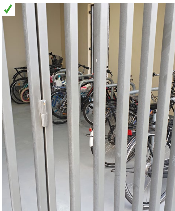
Le local à vélos en position centrale est sécurisé et à proximité des portes d'accès au bâtiment. La grille permet d'avoir une visibilité sur les vélos. ©AQC
