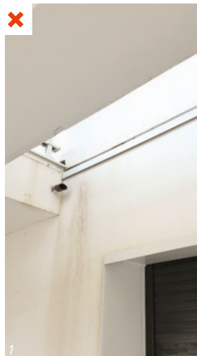
1 Les pissettes superposées des coursives salissent l'enduit de façade et provoquent des nuisances acoustiques dans les logements. ©AQC
