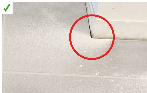
Une bande de rive assure l'isolation acoustique sur tout le pourtour de la cloison. ©AQC
