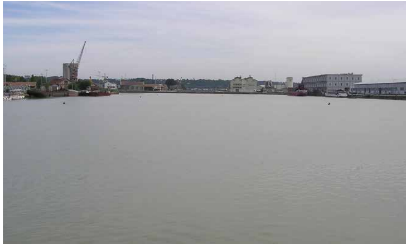
Vue sur le bassin n°1
