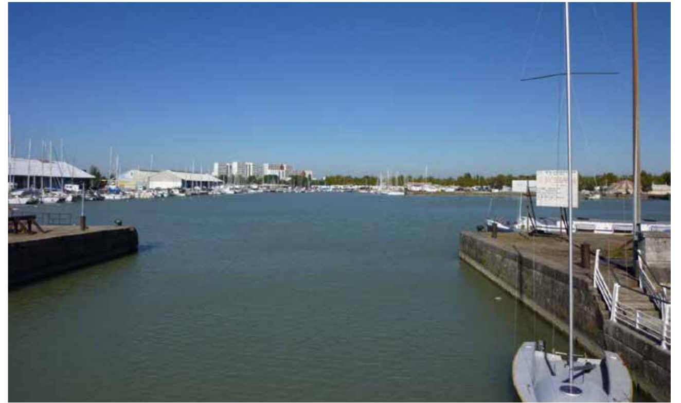
Vue sur le bassin n°2
