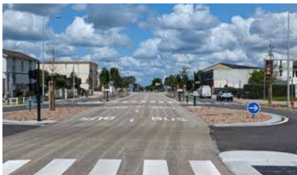
Station Emile Zola, Avenue Pasteur, Le Haillan (ligne Bordeaux-Saint-Aubin de Médoc). Source : Direction générale mobilités - Bordeaux Métropole
