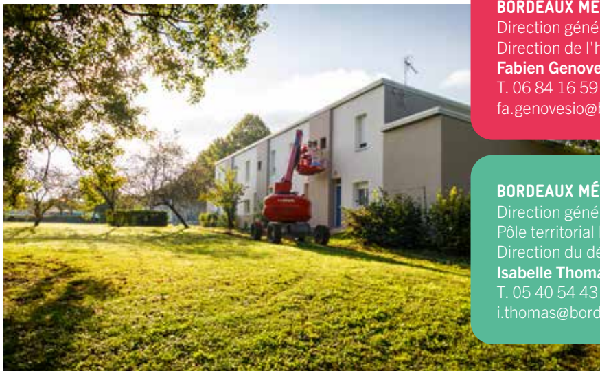
Réhabilitation des logements de la résidence Lafayette par Domofrance (secteur Prévert-Le Moura), octobre 2024. Source : C. Barbier - Bordeaux Métropole
