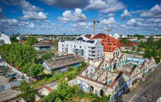
Secteur Caserne Niel, 28 logements en accession sociale Doma et Stego (Axanis) livrés en 2024. Source : Atelier Caumes / SAS d'aménagement Bastide Niel
