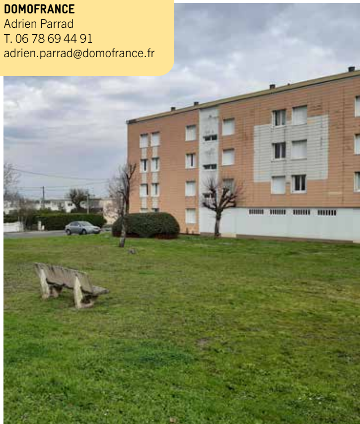
Résidence Bel Air actuellement, logements et espaces collectifs. Source : Bordeaux Métropole.
