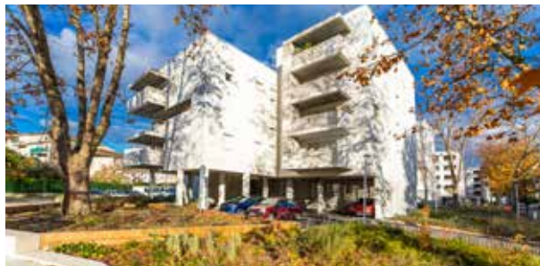
Résidence Aldéa, 40 logements livrés en 2019. Source : Bordeaux Métropole
