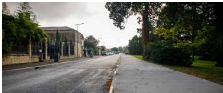
Achèvement de la phase 1 de la voie périphérique rue du Moura (secteur Prévert-Le Moura), octobre 2024. Source : C. Barbier - Bordeaux Métropole
