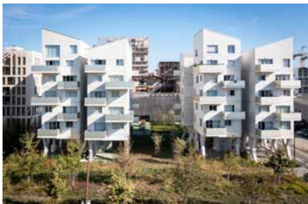
Bâtiments sur pilotis (Aquitanis), octobre 2023. Source : JB Menges - Bordeaux Métropole
