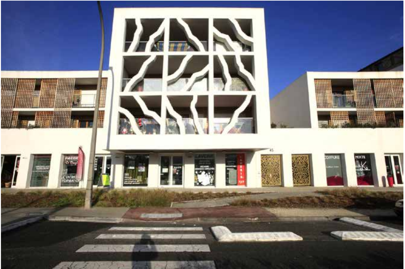
Opérateur : ICF. Développeur : CIRMAD - Architectes : HPL Architectes / Rudy Ricciotti. Source : Bordeaux Métropole
