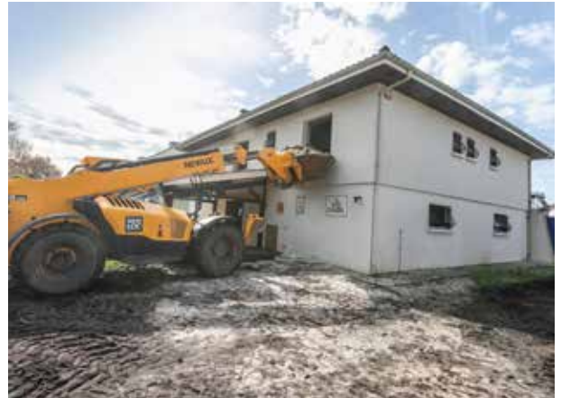
Démolition, mars 2024. Source : Jean-François Humbert
